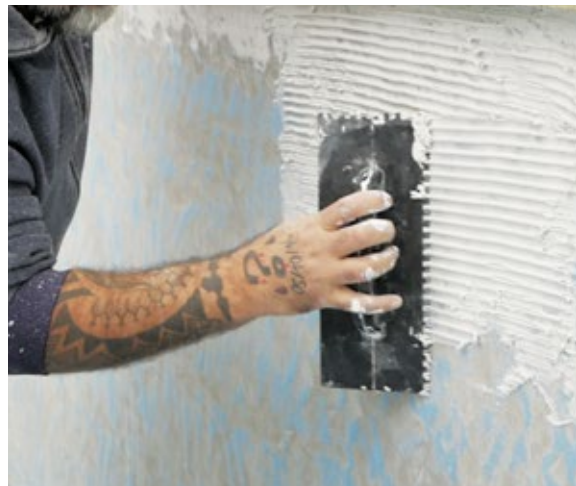
Llanado y uniformidad de la capa.
