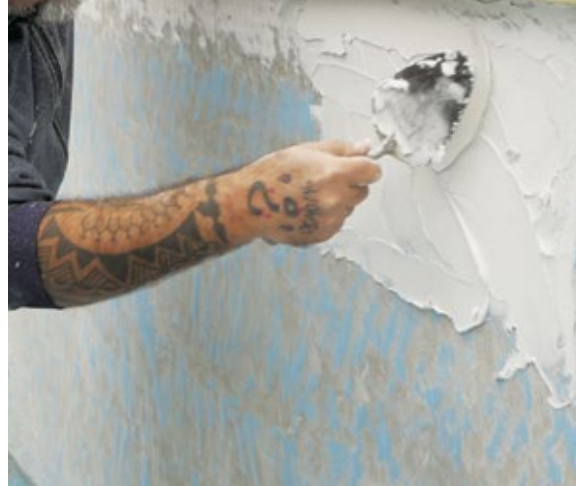
Colocación del adhesivo.
