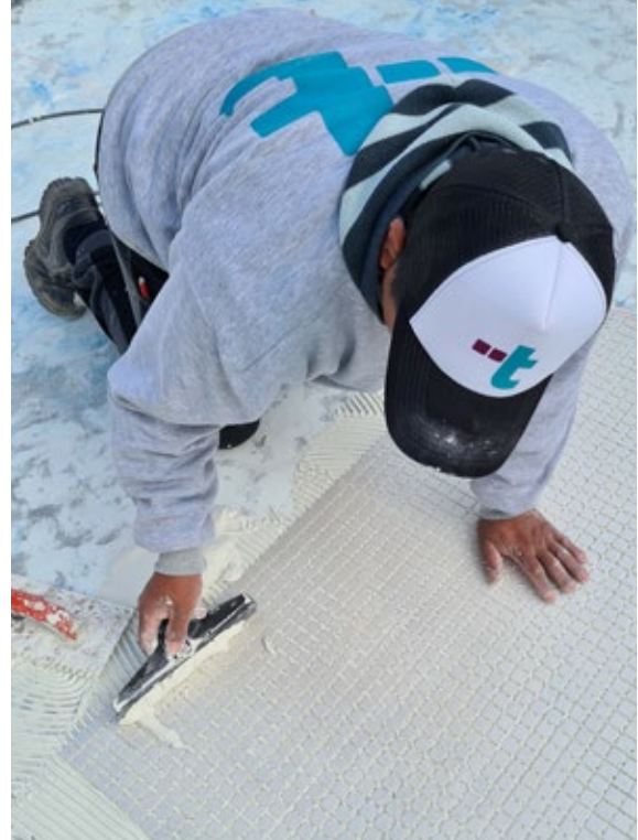
Rellenado de juntas.
