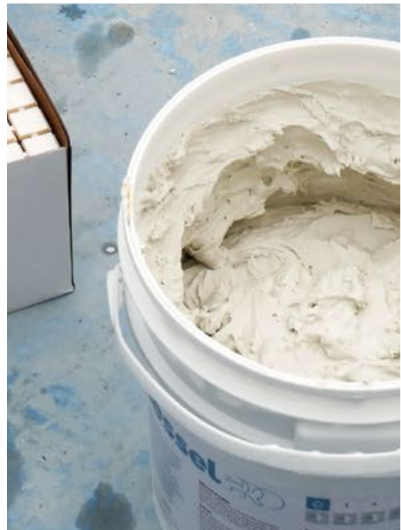
Adhesivo listo para colocar.
